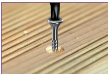
Suite au pré-perçage et au fraisage de la lame, le vissage est facilité.
